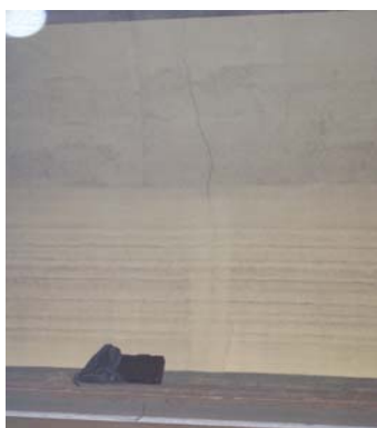
Obr.9.4. Trhlina vo vnútri tunelovej rúry únikovej štólne tunela Branisko (cca 300 m od východného portálu) a namerané posuny pozdĺž zlomu
